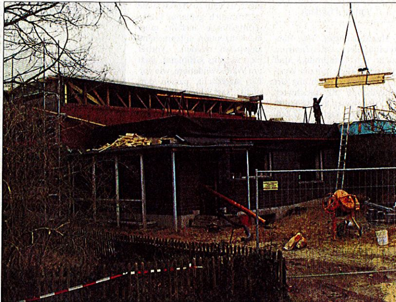
Nach wochenlanger Pause geht der Umbau des Dorfgemeinschaftshauses Soltendieck nun weiter. Die verbogenen Brettbinder im Dach werden mit Holzbalken stabilisiert.
