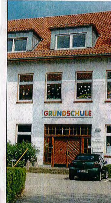
Soll energetisch saniert werden: die Bad Bodenteicher Grundschule. Fotos: phs (2), lw
