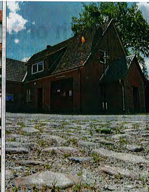
Neue Halle: Das Feuerwehrgerätehaus in Lehmke soll nicht mehr genutzt werden, eine Halle an der Sportstätte des TSV errichtet werden.
