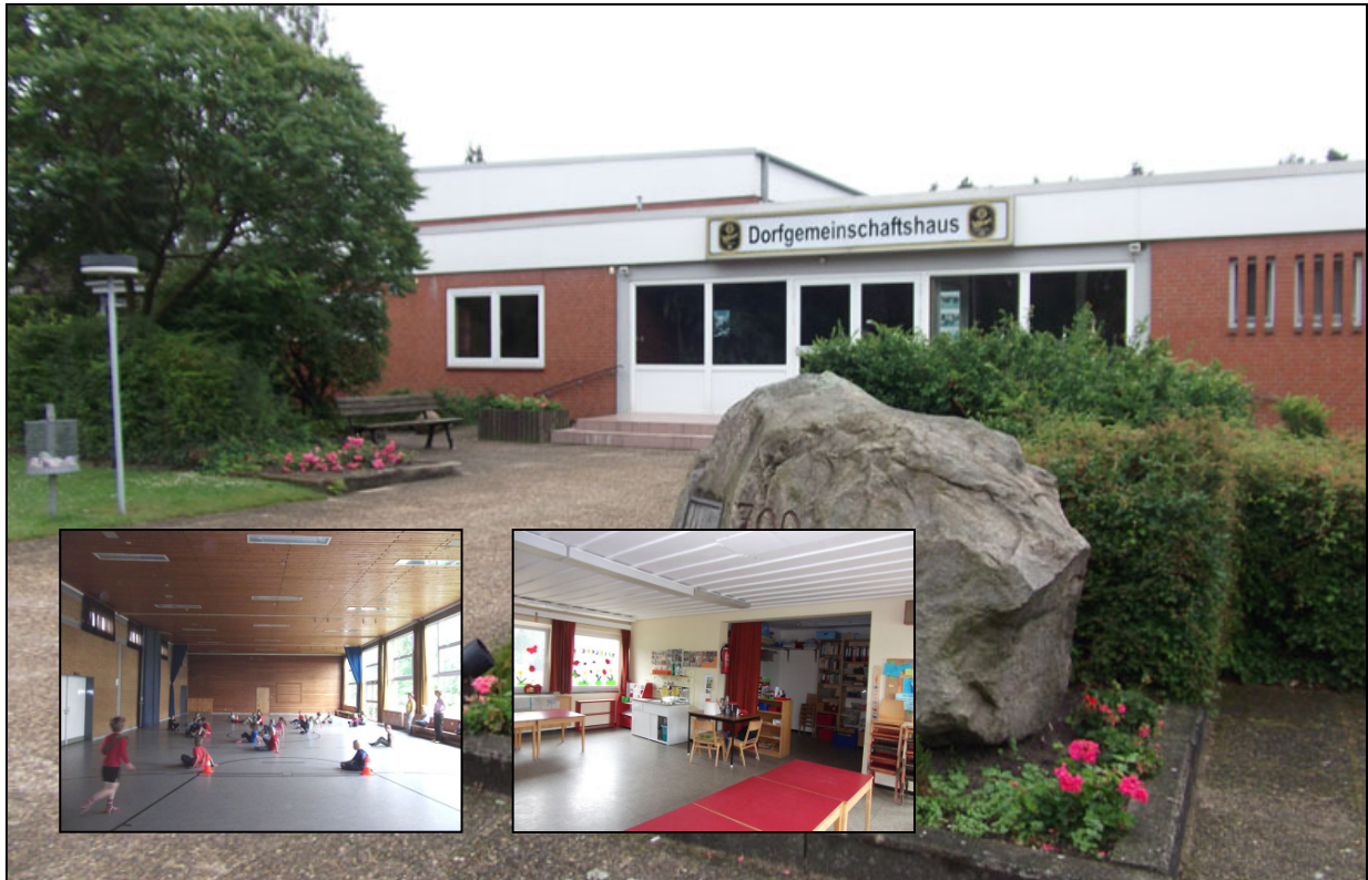
Maßnahme 1: Dorfgemeinschaftshaus mit Spielkreis und Turnhalle in Soltendieck
